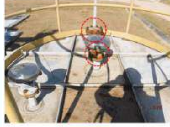
ภาพที่ 250_อุปกรณ์ 3621-D-002 ปัญหา Tag.E-66-06-6010: Flange Stud Bolt & Nut เกิด Corrosion จำนวน 2 ตัว (ClassC)
