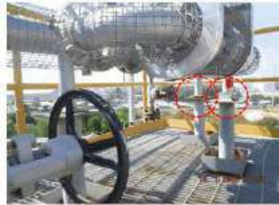
ภาพที่ 116 อุปกรณ์ 3608-D-001 ปัญหา Tag.E-67-06-0032: Support เกิด Corrosion (ClassC)
