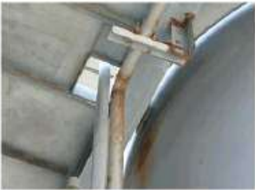
ภาพที่ 77 อุปกรณ์ 3633-D-001 ปัญหา Tag.E-65-06-0078: Pipe Line เกิด Corrosion (Tag.No.E-65-06-0216) (ClassC) ข้อเสนอแนะ : - ควรทำการ Cleaning เพื่อประเมินสภาพพร้อมทั้งเตรียมผิวงานตามมาตรฐาน PTT กำหนด - ควรทำการ Re-Coating ใหม่ให้เรียบร้อยอยู่ในสภาพปกติ
