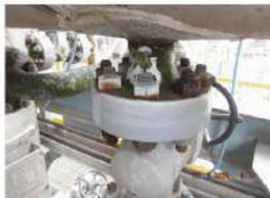
ภาพที่ 70 อุปกรณ์ 3602-D-004 ปัญหา Tag.E-67-06-0116: Stud Bolt & Nut เกิด Corrosion (ClassC)
