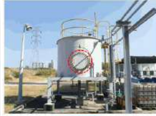
ภาพที่ 249_อุปกรณ์ 3621-D-002 ปัญหา Tag.E-66-06-0302: Nut เกิด Corrosion (ClassC)
