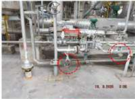
ภาพที่ 69 อุปกรณ์ 3602-D-004 ปัญหา Tag.E-66-06-5021: Flange Stud Bolt & Nut เกิด Corrosion 2 Unit (ClassC)
