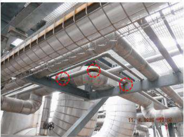
ภาพที่ 28_อุปกรณ์ 3601-S-001 ปัญหา Tag.E-66-06-0250: Pipe Line เกิด Corrosion (ClassB)
