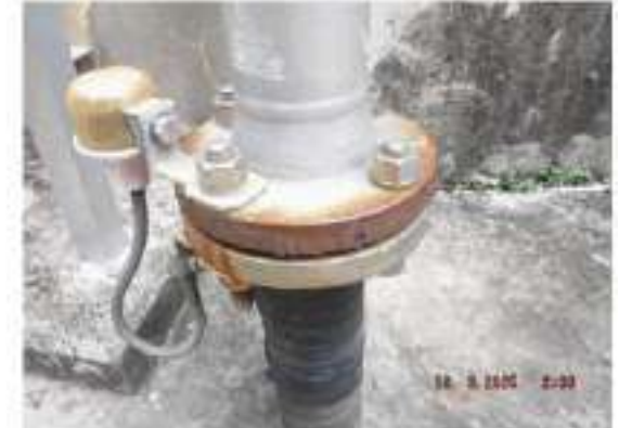
ภาพที่ 26 อุปกรณ์ 3601-1-D-004 ปัญหา Tag.E-67-06-0101: Flange Stud Bolt & Nut เกิด Corrosion (ClassC) ข้อเสนอแนะ : - การทำการ Cleaning เพื่อประเมินสภาพพร้อมทั้งเตรียมผิวงานตามมาตรฐาน PTT กำหนด - การทำการ Re-Coating ใหม่ให้เรียบร้อยอยู่ในสภาพปกติ
