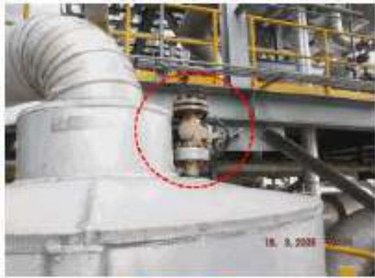
ภาพที่ 56_อุปกรณ์ 3602-D-002 ปัญหา Tag.E-66-06-0196: Gate Valve เกิด Corrosion (ClassC)
