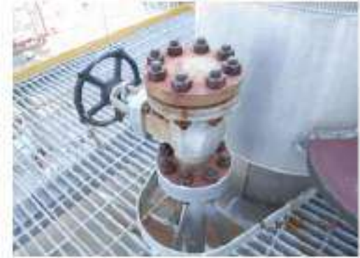
ภาพที่ 222 อุปกรณ์ 3607-D-005 ปัญหา Tag.E-66-06-6035: Flange Stud Bolt & Nut เกิด Corrosion (ClassC)
