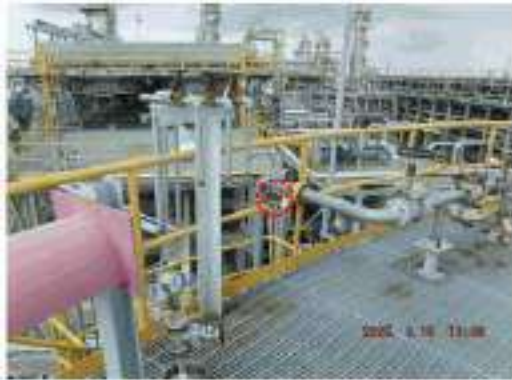
ภาพที่ 14 อุปกรณ์ 3601-1-D-003 ปัญหา Tag.E-63-06-0048: Stud Bolt & Nut เกิดการ Missing ไม่พบการรั่วไหลของสารภายใน (ClassC)
