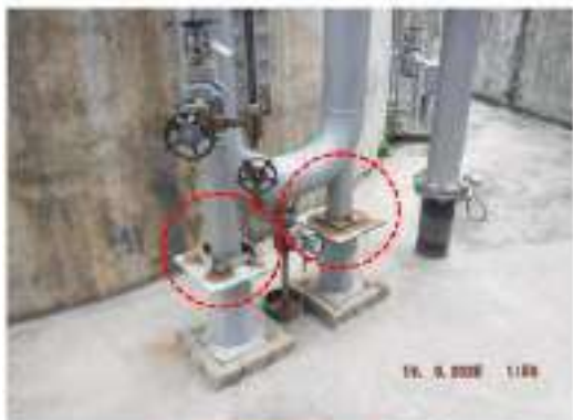
ภาพที่ 2 อุปกรณ์ 3601-1-D-004 ปัญหา Tag.E-68-06-0087: Support เกิด Corrosion (ClassC)
