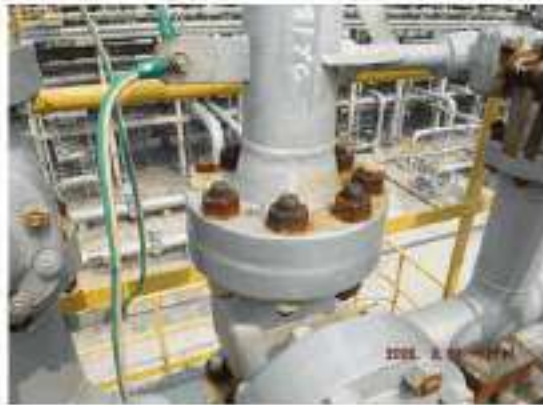
ภาพที่ 74 อุปกรณ์ 3602-D-005 ปัญหา Tag.E-65-06-0198: Stud Bolt & Nut เกิด Corrosion 5 จุด (ClassC)
