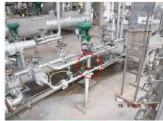
ภาพที่ 72 อุปกรณ์ 3602-D-004 ปัญหา Tag.E-66-06-5022: Support เกิด Corrosion (ClassC)
