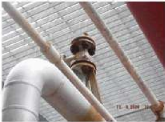
ภาพที่ 26_อุปกรณ์_3601-S-001 ปัญหา Tag.E-66-06-0053: Flange Stud Bolt & Nut เกิด Corrosion (ClassC)
