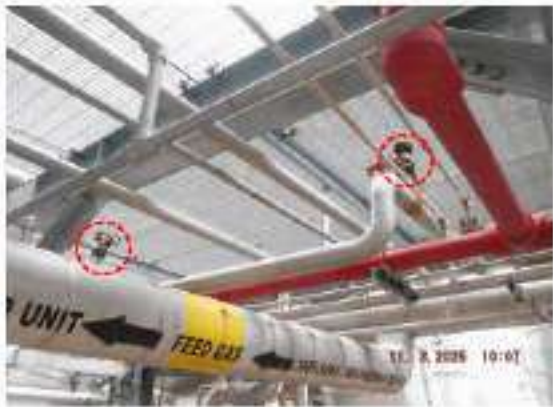
ภาพที่ 26_อุปกรณ์_3601-S-001 ปัญหา Tag.E-66-06-0053: Flange Stud Bolt & Nut เกิด Corrosion (ClassC)
