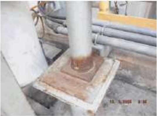
ภาพที่ 1 อุปกรณ์ 3601-2-D-005 ปัญหา Tag.E-68-06-0082: Support เกิด Corrosion (Class C)
