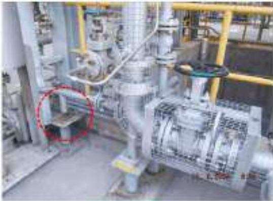
ภาพที่ 1 อุปกรณ์ 3601-2-D-005 ปัญหา Tag.E-68-06-0082: Support เกิด Corrosion (Class C)
