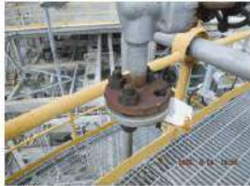
ภาพที่ 14 อุปกรณ์ 3601-1-D-003 ปัญหา Tag.E-63-06-0048: Stud Bolt & Nut เกิดการ Missing ไม่พบการรั่วไหลของสารภายใน (ClassC)
