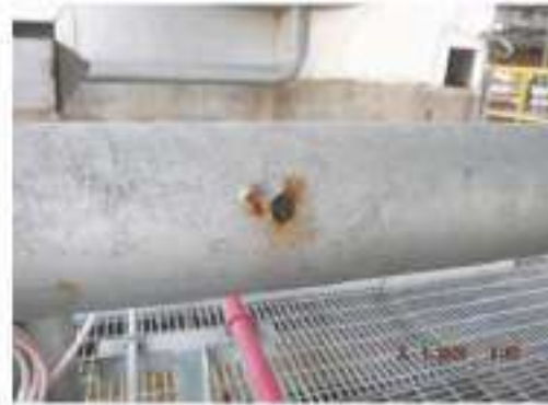
ภาพที่ 23 อุปกรณ์ 3607-D-005 ปัญหา Tag.E-68-06-0030: Pipe Line เกิด Corrosion CML5 (ClassC)
