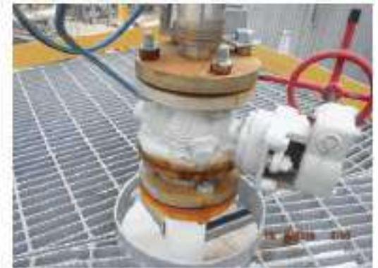
ภาพที่ 22 อุปกรณ์ 3601-1-D-004 ปัญหา Tag.E-67-06-0100: Ball Valve เกิด Corrosion (ClassC)
