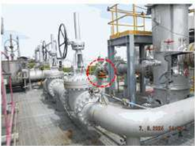
ภาพที่ 107 อุปกรณ์ 3603-S-001 ปัญหา Tag.E-67-06-0161: Flange Stud Bolt & Nut เกิด Corrosion (ClassC)
