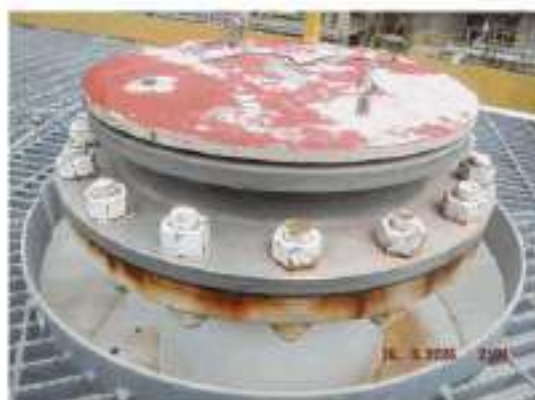
ภาพที่ 25 อุปกรณ์ 3601-1-D-004 ปัญหา Tag.E-66-06-5046: Flange Stud Bolt & Nut เกิด Corrosion (ClassC) ข้อเสนอแนะ : - การทำการ Cleaning เพื่อประเมินสภาพพร้อมทั้งเตรียมผิวงานตามมาตรฐาน PTT กำหนด - การทำการ Re-Coating ใหม่ให้เรียบร้อยอยู่ในสภาพปกติ
