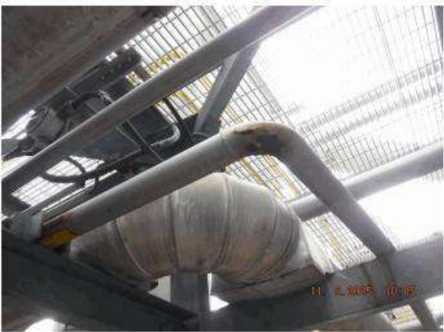
ภาพที่ 28_อุปกรณ์ 3601-S-001 ปัญหา Tag.E-66-06-0250: Pipe Line เกิด Corrosion (ClassB)
