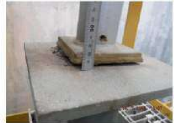
ภาพที่ 46_อุปกรณ์ 3601-1-D-005 ปัญหา Tag.E-66-06-0178: Support เกิด Corrosion & เกิดการหลวมตัวประมาณ 7 mm (ClassB)
