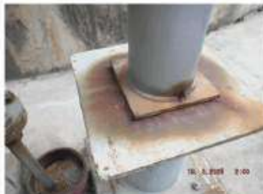
ภาพที่ 2 อุปกรณ์ 3601-1-D-004 ปัญหา Tag.E-68-06-0087: Support เกิด Corrosion (ClassC)
