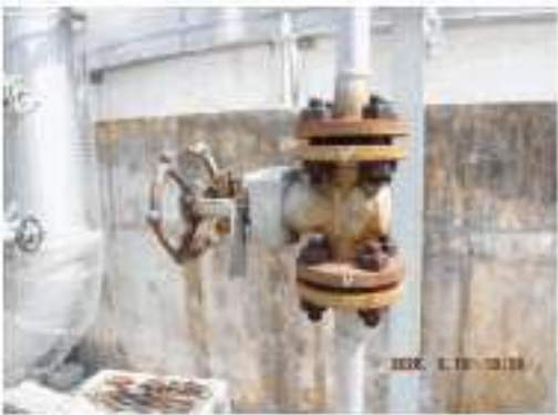
ภาพที่ 18 อุปกรณ์ 3601-1-D-003 ปัญหา Tag.E-65-06-0246: Flange Stud Bolt & Nut เกิด Corrosion 7 จุด (ClassC) ข้อเสนอแนะ : - ควรทำการ Cleaning เพื่อประเมินสภาพพร้อมทั้งเตรียมผิวงานตามมาตรฐาน PTT กำหนด - ควรทำการ Re-Coating (โดยตรวจสอบ check spec.สีที่ใช้ Paint ให้ครอบคลุม Temp การใช้งาน)
