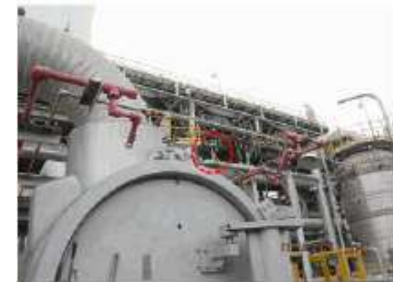
ภาพที่ 25_อุปกรณ์_3601-S-001 ปัญหา Tag.E-66-06-0054: Flange Stud Bolt & Nut เกิด Corrosion (ClassC)
