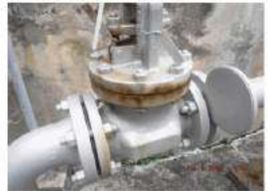
ภาพที่ 23 อุปกรณ์ 3601-1-D-004 ปัญหา Tag.E-65-06-0247: Gate Valve เกิด Corrosion (ClassC)
