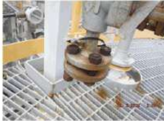
ภาพที่ 24 อุปกรณ์ 3601-1-D-004 ปัญหา Tag.E-55-06-0368: Flange Stud Bolt & Nut เกิดการ Looseness ไม่พบการรั่วไหลของสารภายใน (ClassC) ข้อเสนอแนะ : - การทำการปรับขัน Stud Bolt & Nut ใหม่ให้เรียบร้อยสมบูรณ์อยู่ในสภาพปกติพร้อมใช้งานเพื่อความปลอดภัยของ Plant & บุคคลที่ปฏิบัติงานภายในพื้นที่
