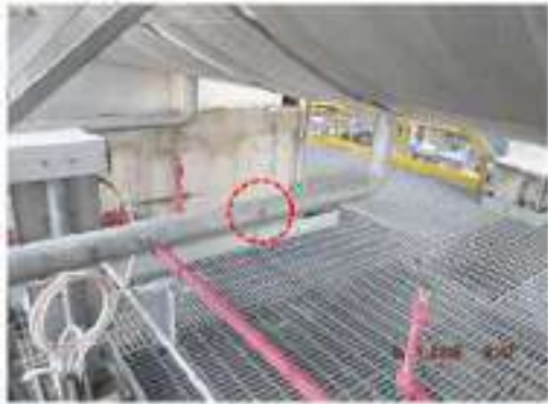
ภาพที่ 23 อุปกรณ์ 3607-D-005 ปัญหา Tag.E-68-06-0030: Pipe Line เกิด Corrosion CML5 (ClassC)
