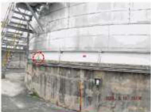
ภาพที่ 19 อุปกรณ์ 3601-1-D-003 ปัญหา Tag.E-67-06-0098: Support เกิด Corrosion รอยร้าวถึงพื้น (ClassC) ข้อเสนอแนะ : - ควรทำการ Cleaning เพื่อประเมินสภาพพร้อมทั้งเตรียมผิวงานตามมาตรฐาน PTT กำหนด - ควรทำการ Re-Coating ใหม่ให้เรียบร้อยอยู่ในสภาพปกติ
