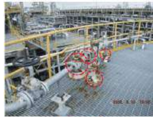
ภาพที่ 17 อุปกรณ์ 3601-1-D-003 ปัญหา Tag.E-67-06-0099: Flange Stud Bolt & Nut เกิด Corrosion (ClassC)
