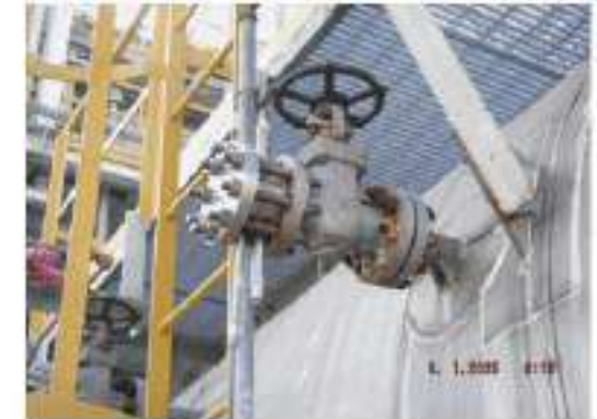
ภาพที่ 225 อุปกรณ์ 3607-D-005 ปัญหา Tag.E-65-06-0289: Stud Bolt & Nut เกิด Corrosion จำนวน 2 จุด (ClassC)
