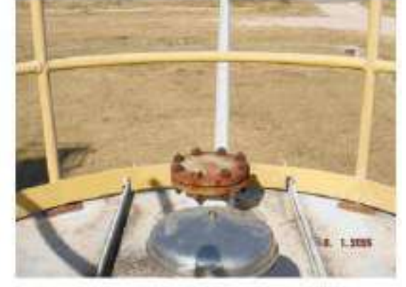
ภาพที่ 250_อุปกรณ์ 3621-D-002 ปัญหา Tag.E-66-06-6010: Flange Stud Bolt & Nut เกิด Corrosion จำนวน 2 ตัว (ClassC)
