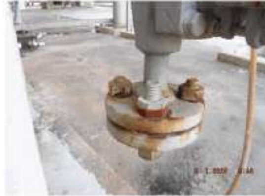
ภาพที่ 224 อุปกรณ์ 3607-D-005 ปัญหา Tag.E-66-06-0335: Flange Stud Bolt & Nut Line Drain เกิด Corrosion 2 จุด (ClassC)
