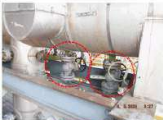
ภาพที่ 70 อุปกรณ์ 3602-D-004 ปัญหา Tag.E-67-06-0116: Stud Bolt & Nut เกิด Corrosion (ClassC)
