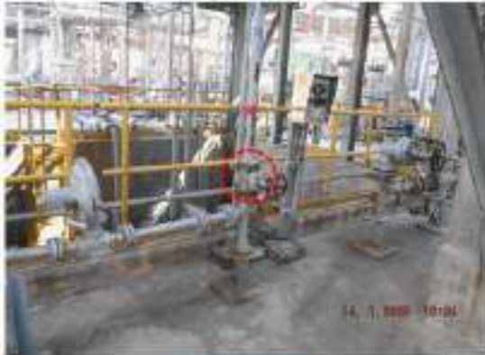
ภาพที่ 44_อุปกรณ์ 3601-1-D-005 ปัญหา Tag.E-67-06-0008: Gate Valve เกิด Corrosion (ClassC)
