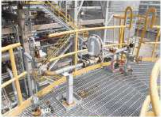
ภาพที่ 24 อุปกรณ์ 3601-1-D-004 ปัญหา Tag.E-55-06-0368: Flange Stud Bolt & Nut เกิดการ Looseness ไม่พบการรั่วไหลของสารภายใน (ClassC) ข้อเสนอแนะ : - การทำการปรับขัน Stud Bolt & Nut ใหม่ให้เรียบร้อยสมบูรณ์อยู่ในสภาพปกติพร้อมใช้งานเพื่อความปลอดภัยของ Plant & บุคคลที่ปฏิบัติงานภายในพื้นที่
