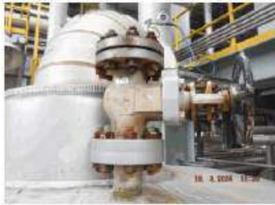
ภาพที่ 56_อุปกรณ์ 3602-D-002 ปัญหา Tag.E-66-06-0196: Gate Valve เกิด Corrosion (ClassC)
