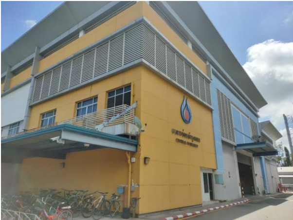
อาคารซ่อมบำรุงเครื่องกล (บง.)
