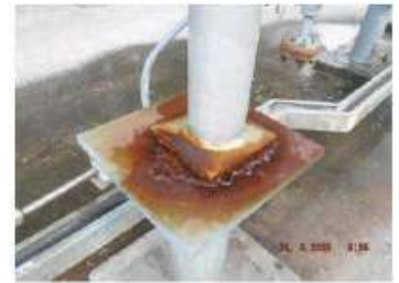
ภาพที่ 72 อุปกรณ์ 3602-D-004 ปัญหา Tag.E-66-06-5022: Support เกิด Corrosion (ClassC)
