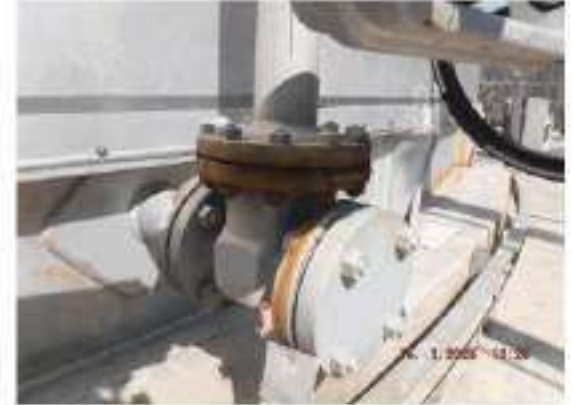
ภาพที่ 112_อุปกรณ์ 3608-D-001 ปัญหา Tag.E-67-06-0028: Gate Valve เกิด Corrosion CML18 (ClassC)
