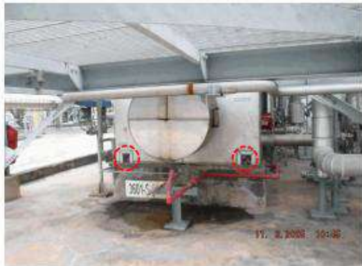
ภาพที่ 32 อุปกรณ์ 3601-S-001R ปัญหา Tag.E-67-06-0086: Stud Bolt & Nut ยึด Support เกิด Corrosion จำนวน 4 ตัว (ClassC)
