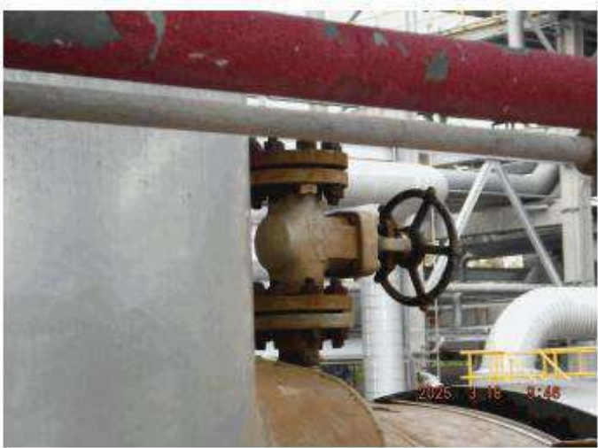
ภาพที่ 108 อุปกรณ์ 3602-S-001R ปัญหา Tag.E-66-06-5042: Gate Valve เกิด Corrosion (ClassC)
