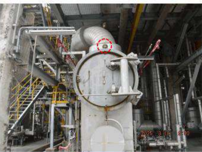
ภาพที่ 108 อุปกรณ์ 3602-S-001R ปัญหา Tag.E-66-06-5042: Gate Valve เกิด Corrosion (ClassC)
