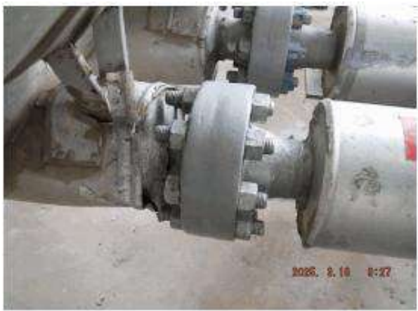
ภาพที่ 107_อุปกรณ์ 3602-S-001 ปัญหา Tag.E-66-06-5041: Cladding เกิดการ Damage (ClassB)
