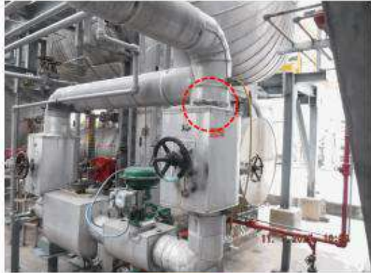
ภาพที่ 31 อุปกรณ์ 3601-S-001R ปัญหา Tag.E-66-06-0057: Cladding เกิดการ Damage เนื่องจาก Silicone ชำรุด (ClassB)
