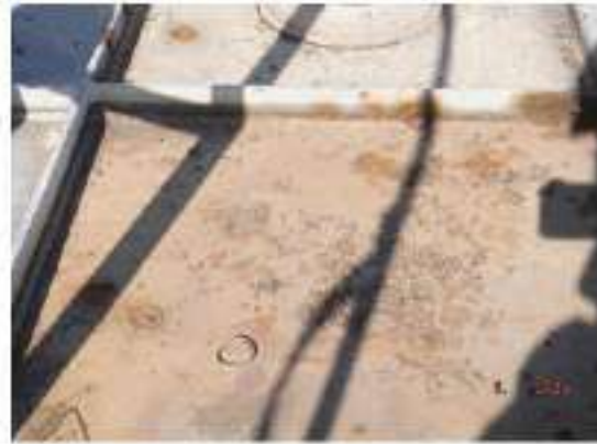
ภาพที่ 247_อุปกรณ์ 3621-D-002 ปัญหา Tag.E-66-06-0300: Body Shell เกิด Corrosion 2 Point (ClassC)
