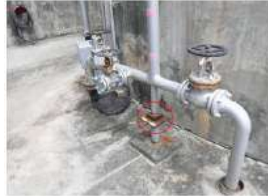
ภาพที่ 27 อุปกรณ์ 3601-1-D-004 ปัญหา Tag.E-65-06-0192: Support เกิด Corrosion (ClassC) ข้อเสนอแนะ : - การทำการ Cleaning เพื่อประเมินสภาพพร้อมทั้งเตรียมผิวงานตามมาตรฐาน PTT กำหนด - การทำการ Re-Coating ใหม่ให้เรียบร้อยอยู่ในสภาพปกติ
