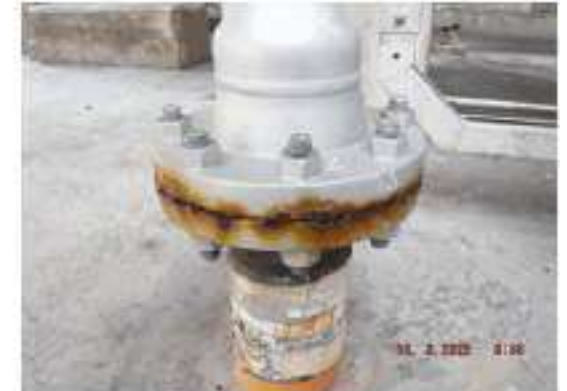
ภาพที่ 71 อุปกรณ์ 3602-D-004 ปัญหา Tag.E-65-06-0197: Flange Stud Bolt & Nut เกิด Corrosion (ClassC)
