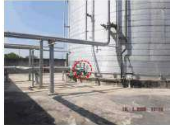
ภาพที่ 112_อุปกรณ์ 3608-D-001 ปัญหา Tag.E-67-06-0028: Gate Valve เกิด Corrosion CML18 (ClassC)
