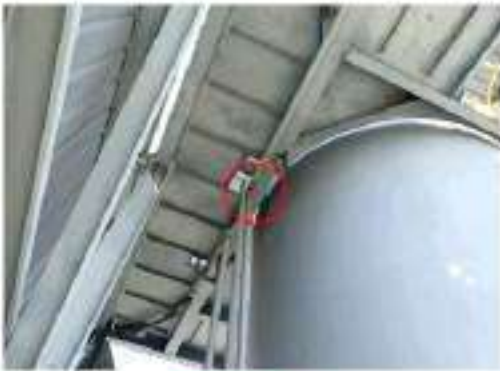
ภาพที่ 77 อุปกรณ์ 3633-D-001 ปัญหา Tag.E-65-06-0078: Pipe Line เกิด Corrosion (Tag.No.E-65-06-0216) (ClassC) ข้อเสนอแนะ : - ควรทำการ Cleaning เพื่อประเมินสภาพพร้อมทั้งเตรียมคิวงานตามมาตรฐาน PTT กำหนด - ควรทำการ Re-Coating ใหม่ให้เรียบร้อยอยู่ในสภาพปกติ
