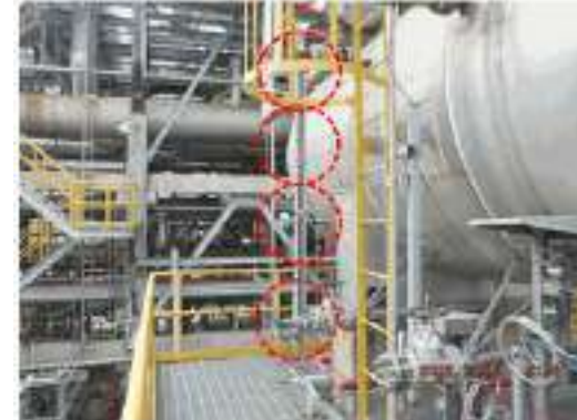
ภาพที่ 226 อุปกรณ์ 3607-D-005 ปัญหา Tag.E-66-06-0336: Sight Glass เกิด Corrosion เนื่องจาก Coatingเสื่อมสภาพ (ClassC)
