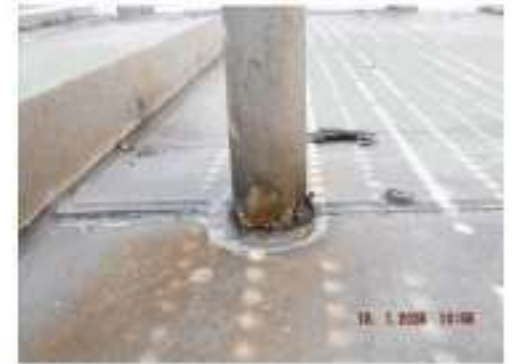
ภาพที่ 120_อุปกรณ์ 3608-D-001 ปัญหา Tag.E-67-06-0034: Pipe Line & Gate Valve เกิด Corrosion CML9 (ClassC)
