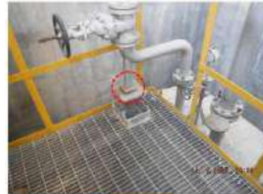
ภาพที่ 46_อุปกรณ์ 3601-1-D-005 ปัญหา Tag.E-66-06-0178: Support เกิด Corrosion & เกิดการหลวมตัวประมาณ 7 mm (ClassB)
