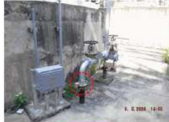
ภาพที่ 26 อุปกรณ์ 3601-1-D-004 ปัญหา Tag.E-67-06-0101: Flange Stud Bolt & Nut เกิด Corrosion (ClassC) ข้อเสนอแนะ : - การทำการ Cleaning เพื่อประเมินสภาพพร้อมทั้งเตรียมผิวงานตามมาตรฐาน PTT กำหนด - การทำการ Re-Coating ใหม่ให้เรียบร้อยอยู่ในสภาพปกติ
