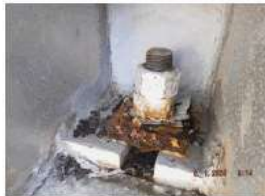
ภาพที่ 227 อุปกรณ์ 3607-D-005 ปัญหา Tag.E-66-06-6034: Stud Bolt & Nut เกิด Corrosion 4จุด (ClassC)
