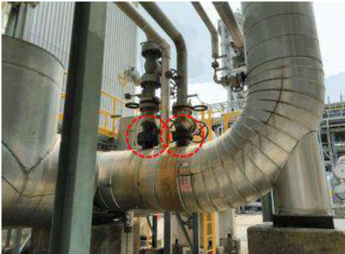
ภาพที่ 100 อุปกรณ์ 3602-S-002R ปัญหา Tag.E-67-06-0127: Corrosion (ClassC)
