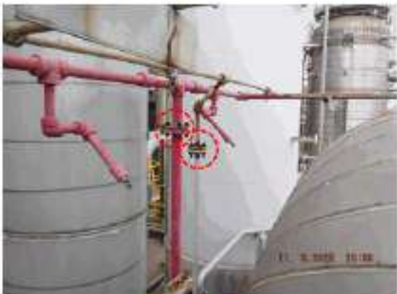
ภาพที่ 24_อุปกรณ์_3601-S-001 ปัญหา Tag.E-66-06-0052: Stud Bolt & Nut เกิด Corrosion 2 Point (ClassC)
