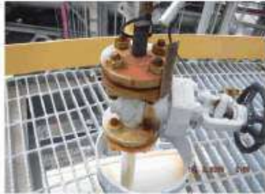
ภาพที่ 1 อุปกรณ์ 3601-1-D-004 ปัญหา Tag.E-68-06-0086: Gate Valve เกิด Corrosion (ClassC)
