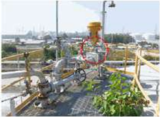
ภาพที่ 114 อุปกรณ์ 3608-D-001 ปัญหา Tag.E-67-06-0033: Bonnet Globe Valve เกิด Corrosion (ClassC)
