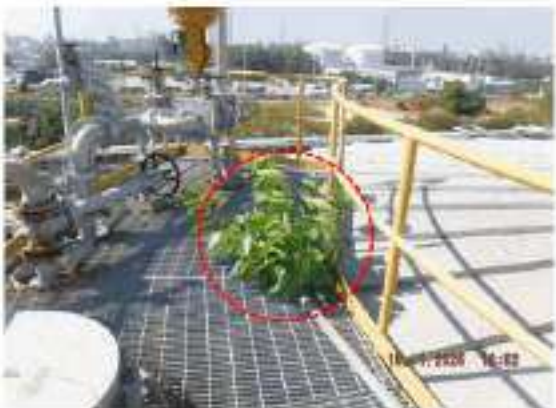
ภาพที่ 119_อุปกรณ์ 3608-D-001 ปัญหา Tag.E-64-06-0002: พบวัชพืชขึ้น บริเวณ Body 2 จุด (ClassB)
