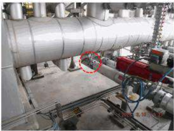
ภาพที่ 107_อุปกรณ์ 3602-S-001 ปัญหา Tag.E-66-06-5041: Cladding เกิดการ Damage (ClassB)
