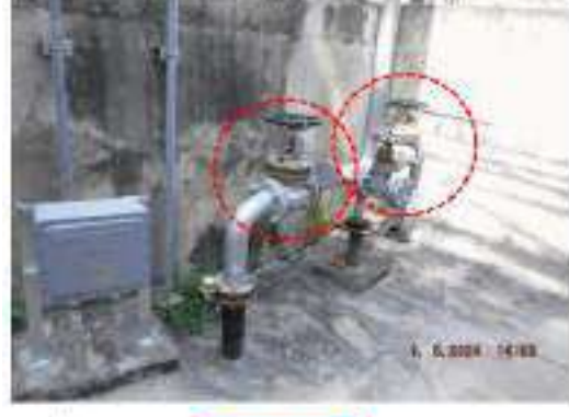
ภาพที่ 23 อุปกรณ์ 3601-1-D-004 ปัญหา Tag.E-65-06-0247: Gate Valve เกิด Corrosion (ClassC)
