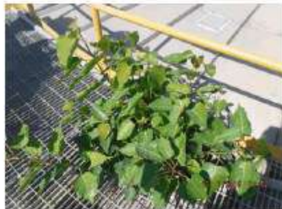
ภาพที่ 119_อุปกรณ์ 3608-D-001 ปัญหา Tag.E-64-06-0002: พบวัชพืชขึ้น บริเวณ Body 2 จุด (ClassB)
