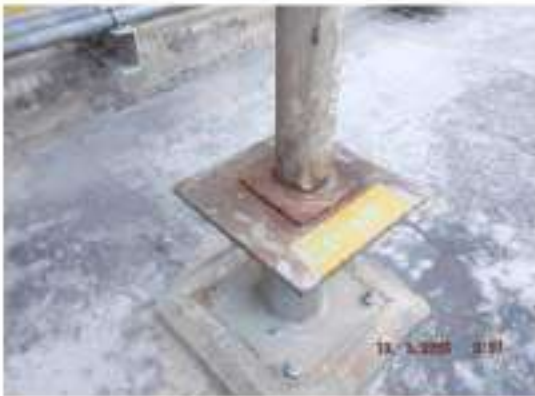
ภาพที่ 2 อุปกรณ์ 3601-2-D-005 ปัญหา Tag.E-68-06-0083: Support เกิด Corrosion (Class C)
