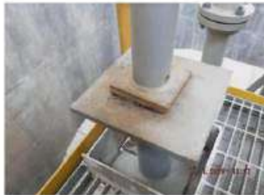
ภาพที่ 45_อุปกรณ์ 3601-1-D-005 ปัญหา Tag.E-67-06-0007: Support เกิด Corrosion (ClassC)
