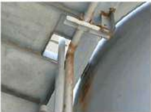
ภาพที่ 76 อุปกรณ์ 3633-D-001 ปัญหา Tag.E-65-06-0190: Body shell เกิด Corrosion 2 จุด (Tag.No.E-65-06-0210) (ClassC) ข้อเสนอแนะ : - ควรทำการ Cleaning เพื่อประเมินสภาพพร้อมทั้งเตรียมคิวงานตามมาตรฐาน PTT กำหนด - ควรทำการ Re-Coating ใหม่ให้เรียบร้อยอยู่ในสภาพปกติ
