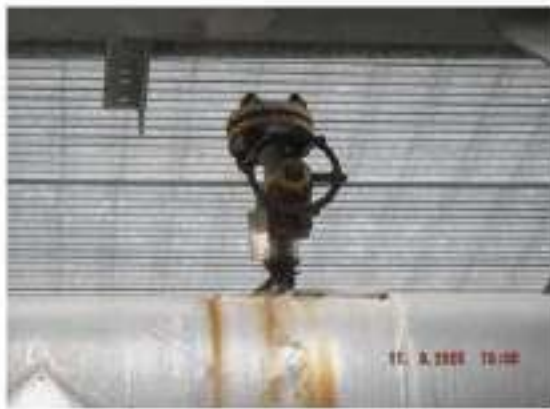
ภาพที่ 27_อุปกรณ์_3601-S-001 ปัญหา Tag.E-66-06-0249: Line Drain เกิด Corrosion (ClassB)
