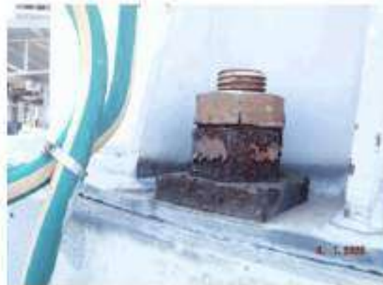
ภาพที่ 248_อุปกรณ์ 3621-D-002 ปัญหา Tag.E-66-06-0301: Nut เกิด Corrosion (ClassC)
