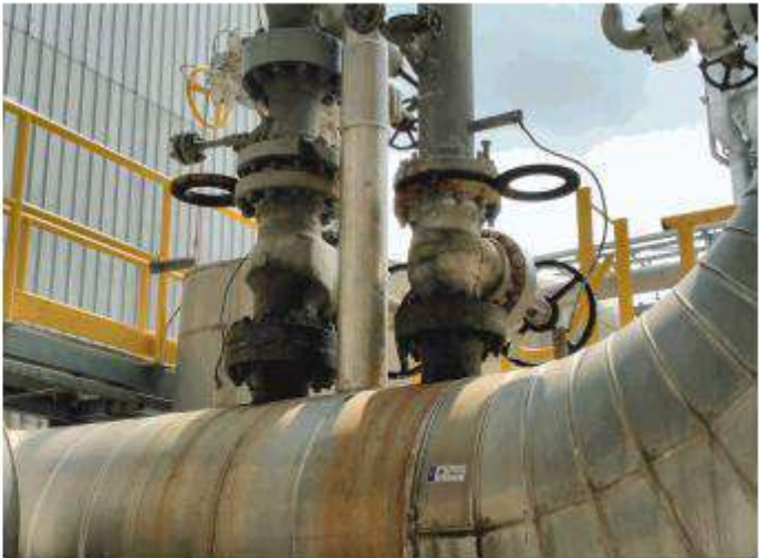
ภาพที่ 100 อุปกรณ์ 3602-S-002R ปัญหา Tag.E-67-06-0127: Corrosion (ClassC)
