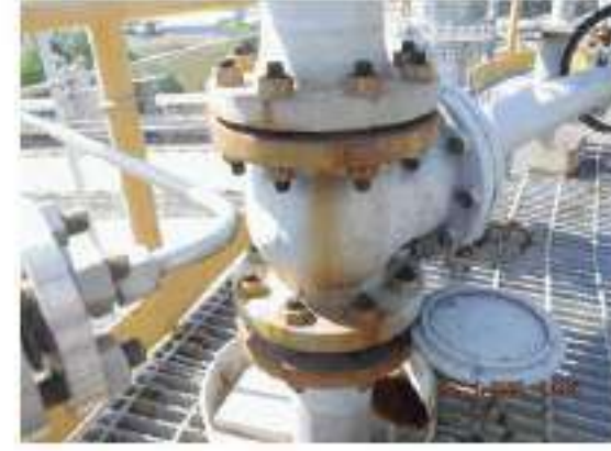
ภาพที่ 115 อุปกรณ์ 3608-D-001 ปัญหา Tag.E-67-06-0029: Flange Stud Bolt & Nut เกิด Corrosion (ClassC)
