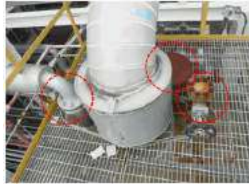
ภาพที่ 222 อุปกรณ์ 3607-D-005 ปัญหา Tag.E-66-06-6035: Flange Stud Bolt & Nut เกิด Corrosion (ClassC)
