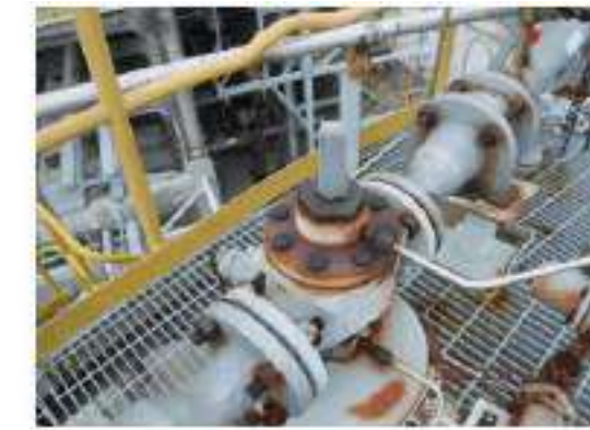
ภาพที่ 17 อุปกรณ์ 3601-1-D-003 ปัญหา Tag.E-67-06-0099: Flange Stud Bolt & Nut เกิด Corrosion (ClassC)
