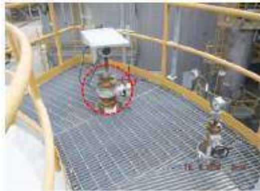
ภาพที่ 22 อุปกรณ์ 3601-1-D-004 ปัญหา Tag.E-67-06-0100: Ball Valve เกิด Corrosion (ClassC)
