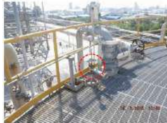
ภาพที่ 113_อุปกรณ์ 3608-D-001 ปัญหา Tag.E-67-06-0030: Gate Valve เกิด Corrosion CML10 (ClassC)
