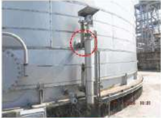
ภาพที่ 29_อุปกรณ์ 3608-D-001 ปัญหา Tag.E-68-06-0039: Flange Stud Bolt & Nut เกิด Corrosion CML13 (ClassC)
