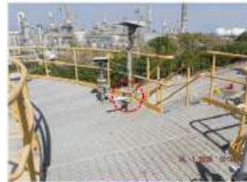
ภาพที่ 120_อุปกรณ์ 3608-D-001 ปัญหา Tag.E-67-06-0034: Pipe Line & Gate Valve เกิด Corrosion CML9 (ClassC)
