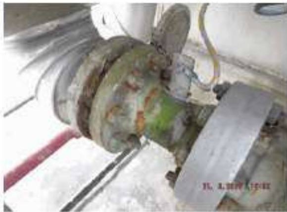
ภาพที่ 29 อุปกรณ์ 3601-S-001R ปัญหา Tag.E-66-06-0056: Flange Stud Bolt & Nut เกิด Corrosion (ClassC)
