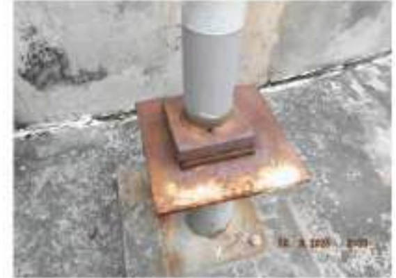
ภาพที่ 27 อุปกรณ์ 3601-1-D-004 ปัญหา Tag.E-65-06-0192: Support เกิด Corrosion (ClassC) ข้อเสนอแนะ : - การทำการ Cleaning เพื่อประเมินสภาพพร้อมทั้งเตรียมผิวงานตามมาตรฐาน PTT กำหนด - การทำการ Re-Coating ใหม่ให้เรียบร้อยอยู่ในสภาพปกติ
