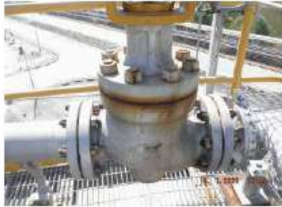
ภาพที่ 114 อุปกรณ์ 3608-D-001 ปัญหา Tag.E-67-06-0033: Bonnet Globe Valve เกิด Corrosion (ClassC)
