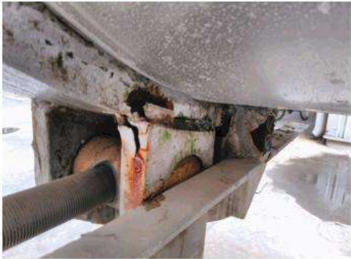
ภาพที่ 110 อุปกรณ์ 3602-S-002R ปัญหา Tag.E-67-06-0127: Support เกิด Corrosion (ClassC)
