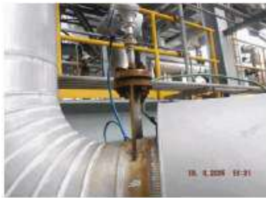
ภาพที่ 57_อุปกรณ์ 3602-D-002 ปัญหา Tag.E-66-06-5013: Flange Stud Bolt & Nut เกิด Corrosion (ClassC)
