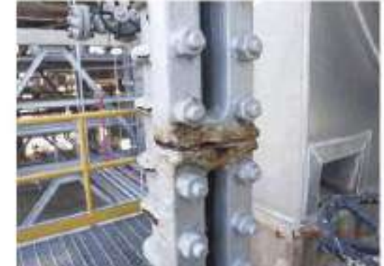
ภาพที่ 226 อุปกรณ์ 3607-D-005 ปัญหา Tag.E-66-06-0336: Sight Glass เกิด Corrosion เนื่องจาก Coatingเสื่อมสภาพ (ClassC)
