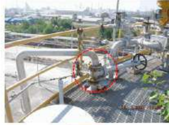
ภาพที่ 115 อุปกรณ์ 3608-D-001 ปัญหา Tag.E-67-06-0029: Flange Stud Bolt & Nut เกิด Corrosion (ClassC)
