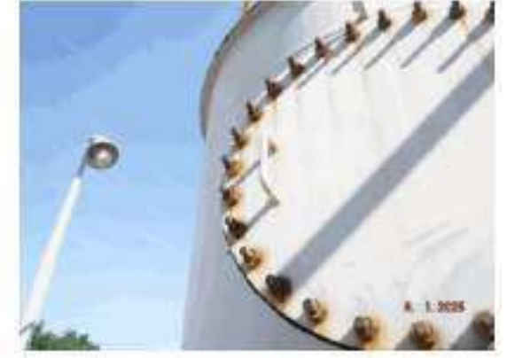
ภาพที่ 249_อุปกรณ์ 3621-D-002 ปัญหา Tag.E-66-06-0302: Nut เกิด Corrosion (ClassC)
