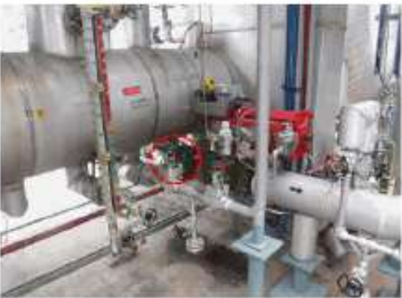
ภาพที่ 29 อุปกรณ์ 3601-S-001R ปัญหา Tag.E-66-06-0056: Flange Stud Bolt & Nut เกิด Corrosion (ClassC)
