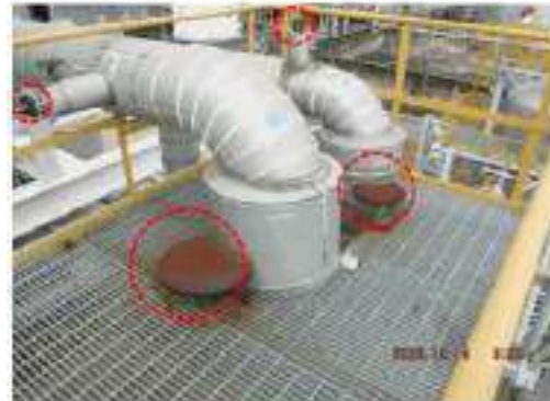
ภาพที่ 223 อุปกรณ์ 3607-D-005 ปัญหา Tag.E-66-06-6036: Blind Flange Flange Stud Bolt & Nut เกิด Corrosion 4 จุด (ClassC)
