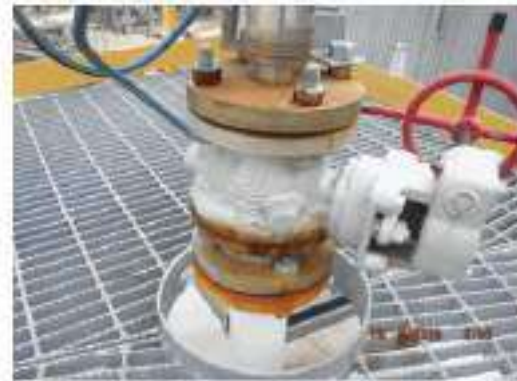
ภาพที่ 22 อุปกรณ์ 3601-1-D-004 ปัญหา Tag.E-67-06-0100: Ball Valve เกิด Corrosion (ClassC)
