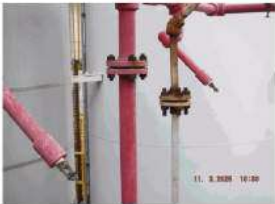
ภาพที่ 24_อุปกรณ์_3601-S-001 ปัญหา Tag.E-66-06-0052: Stud Bolt & Nut เกิด Corrosion 2 Point (ClassC)
