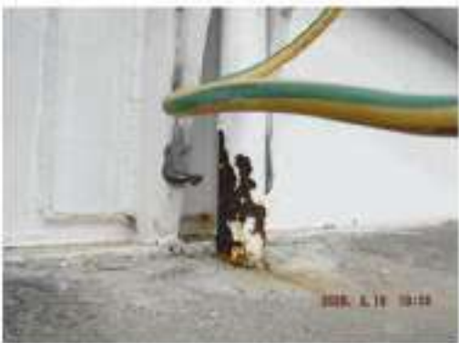
ภาพที่ 19 อุปกรณ์ 3601-1-D-003 ปัญหา Tag.E-67-06-0098: Support เกิด Corrosion รอยร้าวถึงพื้น (ClassC)
