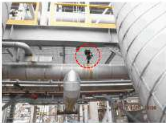
ภาพที่ 27_อุปกรณ์_3601-S-001 ปัญหา Tag.E-66-06-0249: Line Drain เกิด Corrosion (ClassB)
