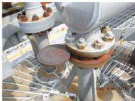
ภาพที่ 75 อุปกรณ์ 3602-D-005 ปัญหา Tag.E-65-06-0258: Flange Stud Bolt & Nut เกิด Corrosion (ClassC)
