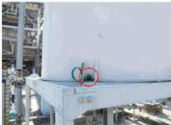
ภาพที่ 248_อุปกรณ์ 3621-D-002 ปัญหา Tag.E-66-06-0301: Nut เกิด Corrosion (ClassC)
