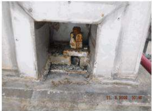
ภาพที่ 32 อุปกรณ์ 3601-S-001R ปัญหา Tag.E-67-06-0086: Stud Bolt & Nut ยึด Support เกิด Corrosion จำนวน 4 ตัว (ClassC)
