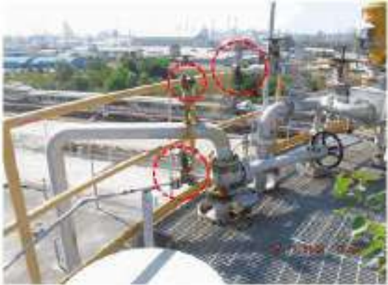
ภาพที่ 118_อุปกรณ์ 3608-D-001 ปัญหา Tag.E-66-06-0022: Stud Bolt & Nut เกิด Corrosion 4 จุด (ClassC)
