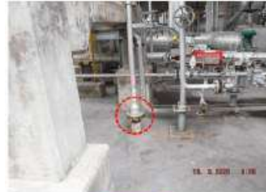
ภาพที่ 71 อุปกรณ์ 3602-D-004 ปัญหา Tag.E-65-06-0197: Flange Stud Bolt & Nut เกิด Corrosion (ClassC)
