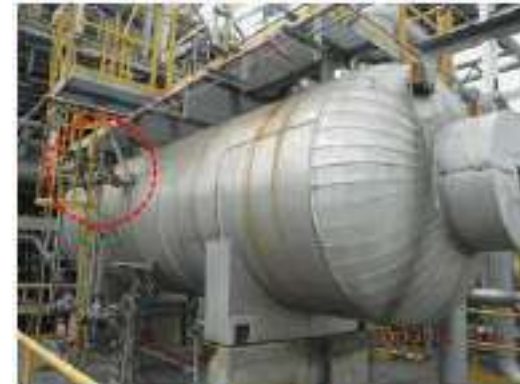
ภาพที่ 225 อุปกรณ์ 3607-D-005 ปัญหา Tag.E-65-06-0289: Stud Bolt & Nut เกิด Corrosion จำนวน 2 จุด (ClassC)
