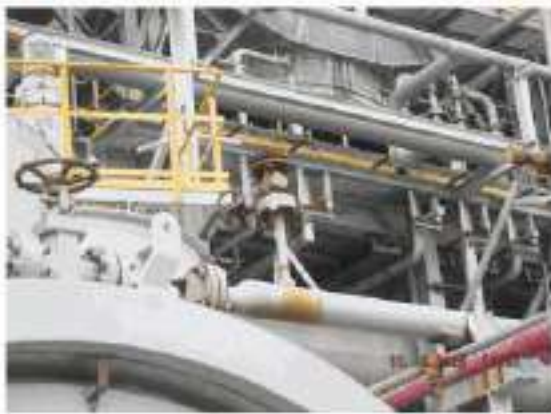
ภาพที่ 25_อุปกรณ์_3601-S-001 ปัญหา Tag.E-66-06-0054: Flange Stud Bolt & Nut เกิด Corrosion (ClassC)
