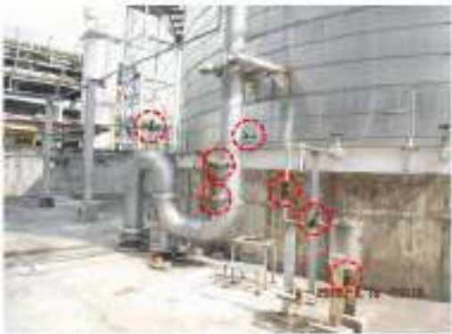
ภาพที่ 18 อุปกรณ์ 3601-1-D-003 ปัญหา Tag.E-65-06-0246: Flange Stud Bolt & Nut เกิด Corrosion 7 จุด (ClassC)
