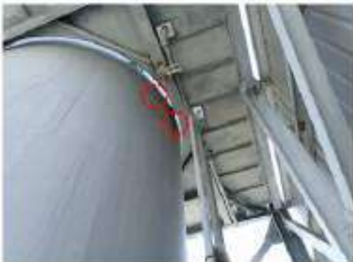
ภาพที่ 76 อุปกรณ์ 3633-D-001 ปัญหา Tag.E-65-06-0190: Body shell เกิด Corrosion 2 จุด (Tag.No.E-65-06-0210) (ClassC) ข้อเสนอแนะ : - ควรทำการ Cleaning เพื่อประเมินสภาพพร้อมทั้งเตรียมคิวงานตามมาตรฐาน PTT กำหนด - ควรทำการ Re-Coating ใหม่ให้เรียบร้อยอยู่ในสภาพปกติ
