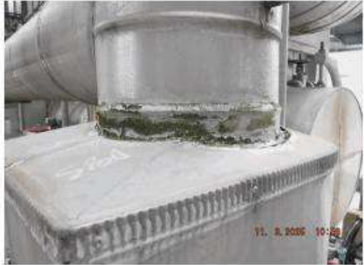
ภาพที่ 31 อุปกรณ์ 3601-S-001R ปัญหา Tag.E-66-06-0057: Cladding เกิดการ Damage เนื่องจาก Silicone ชำรุด (ClassB)
