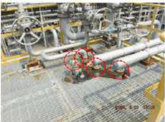
ภาพที่ 75 อุปกรณ์ 3602-D-005 ปัญหา Tag.E-65-06-0258: Flange Stud Bolt & Nut เกิด Corrosion (ClassC)
