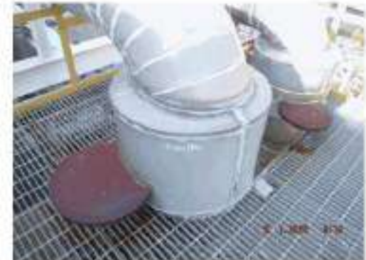
ภาพที่ 223 อุปกรณ์ 3607-D-005 ปัญหา Tag.E-66-06-6036: Blind Flange Flange Stud Bolt & Nut เกิด Corrosion 4 จุด (ClassC)
