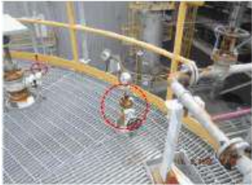
ภาพที่ 1 อุปกรณ์ 3601-1-D-004 ปัญหา Tag.E-68-06-0086: Gate Valve เกิด Corrosion (ClassC)
