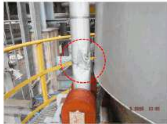
ภาพที่ 58_อุปกรณ์ 3602-D-002 ปัญหา Tag.E-66-06-5014: Cladding เกิดการ Damage (ClassB)
