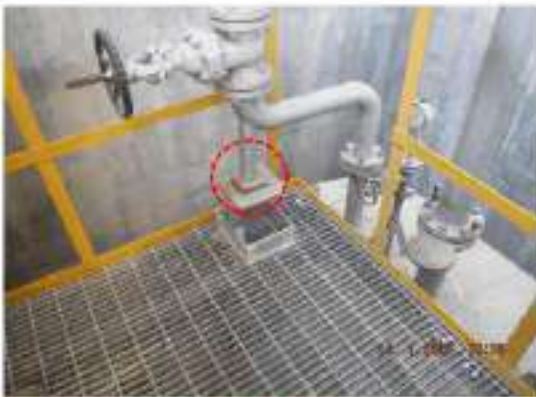
ภาพที่ 45_อุปกรณ์ 3601-1-D-005 ปัญหา Tag.E-67-06-0007: Support เกิด Corrosion (ClassC)
