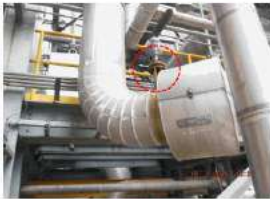
ภาพที่ 57_อุปกรณ์ 3602-D-002 ปัญหา Tag.E-66-06-5013: Flange Stud Bolt & Nut เกิด Corrosion (ClassC)
