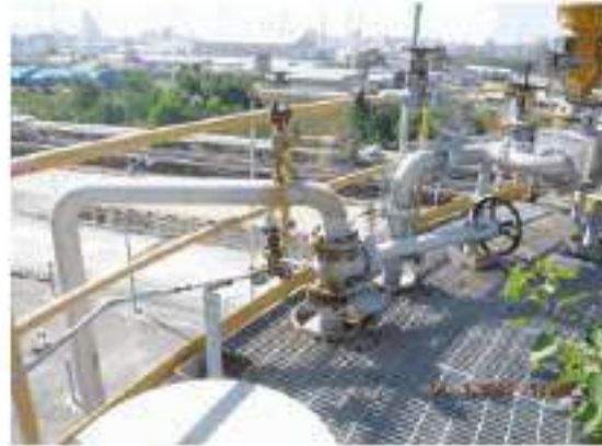
ภาพที่ 118_อุปกรณ์ 3608-D-001 ปัญหา Tag.E-66-06-0022: Stud Bolt & Nut เกิด Corrosion 4 จุด (ClassC)
