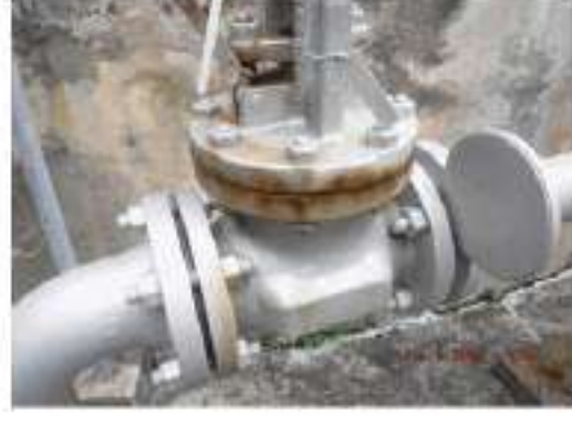
ภาพที่ 23 อุปกรณ์ 3601-1-D-004 ปัญหา Tag.E-65-06-0247: Gate Valve เกิด Corrosion (ClassC)
