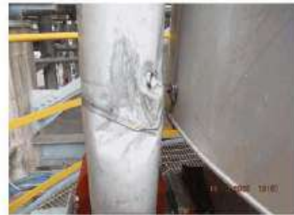
ภาพที่ 58_อุปกรณ์ 3602-D-002 ปัญหา Tag.E-66-06-5014: Cladding เกิดการ Damage (ClassB)
