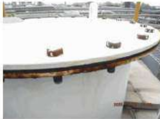
ภาพที่ 15 อุปกรณ์ 3601-1-D-003 ปัญหา Tag.E-66-06-0252: Flange Stud Bolt & Nut เกิด Corrosion (ClassC)
