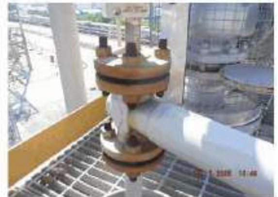
ภาพที่ 113_อุปกรณ์ 3608-D-001 ปัญหา Tag.E-67-06-0030: Gate Valve เกิด Corrosion CML10 (ClassC)
